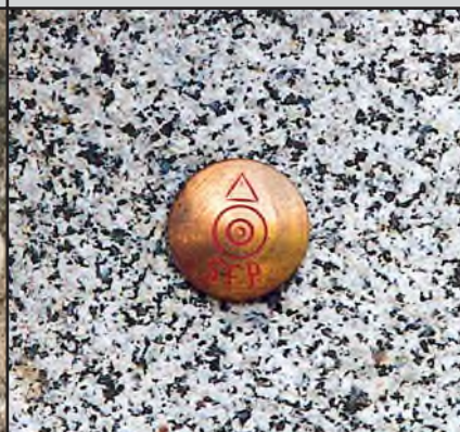
SFP Messingbolzen Ø 3 cm
